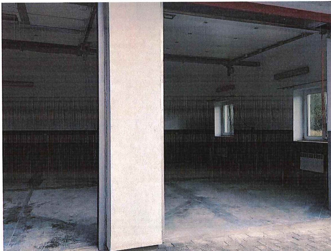
Remont strażnicy OSP Szyszki w ramach zadania "Mazowieckie Strażnice OSP-2022"
