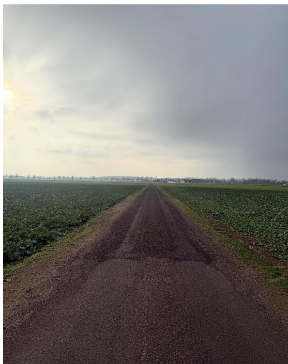
Droga utwardzona emulsją asfaltową w miejscowości Stare Grochy
