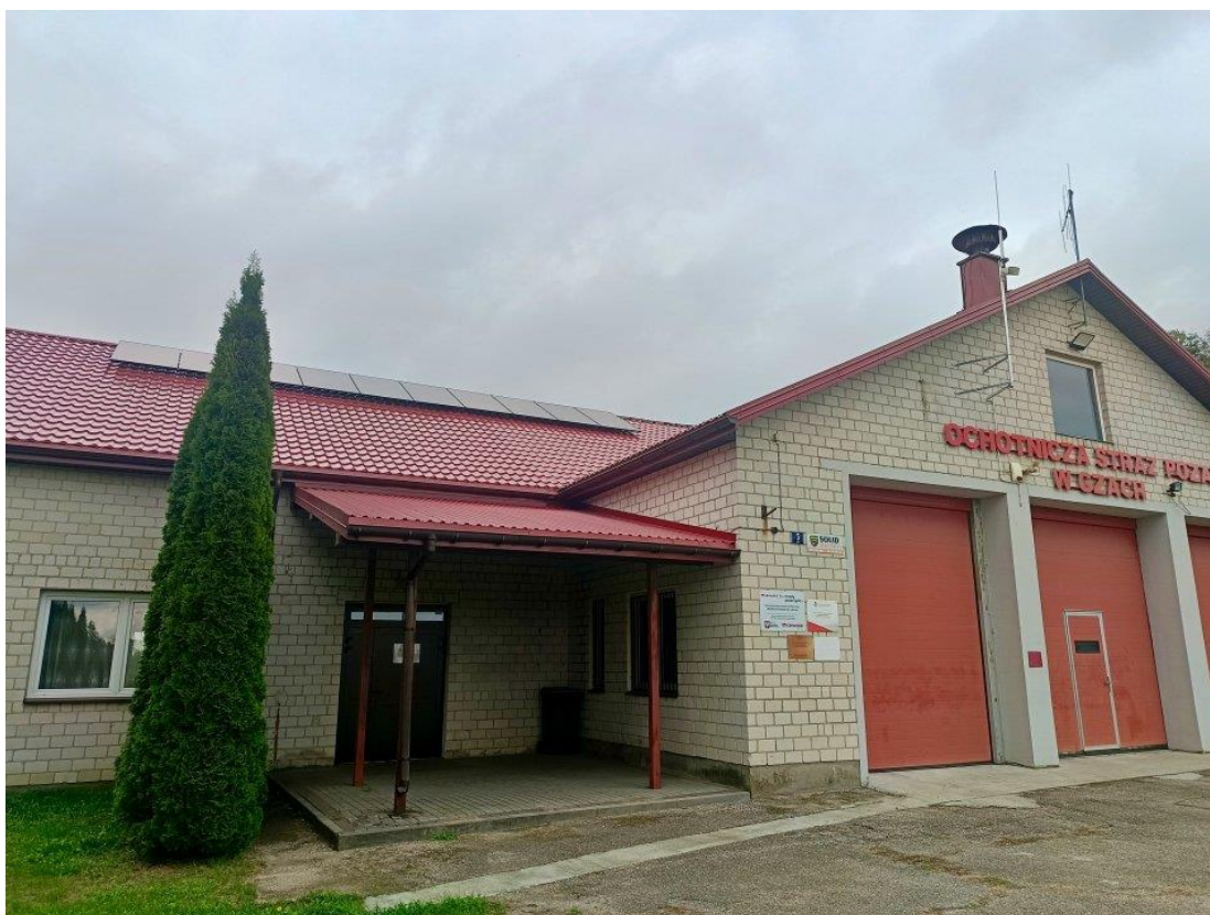
Instalacja fotowoltaiczna zamontowana na dachu budynku Ochotniczej Straży Pożarnej w Gzach
