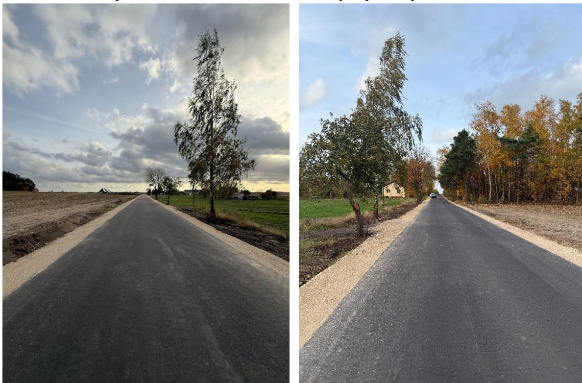
Przebudowa drogi gminnej nr 340120W na odcinku Gotardy - Kościeszce
