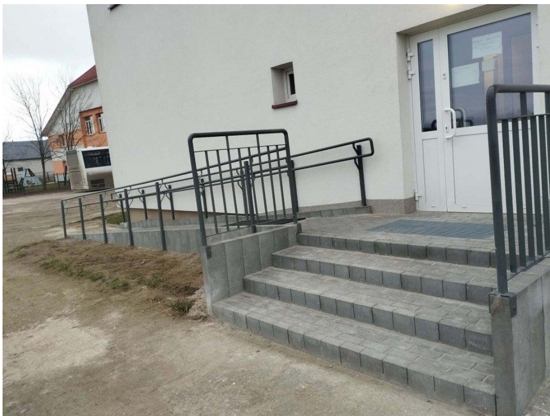
Modernizacja hali sportowej w Gzach
