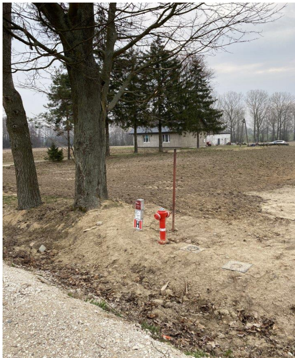
Elementy infrastruktury wodociągowej w miejscowości Przewodowo-Parcele
