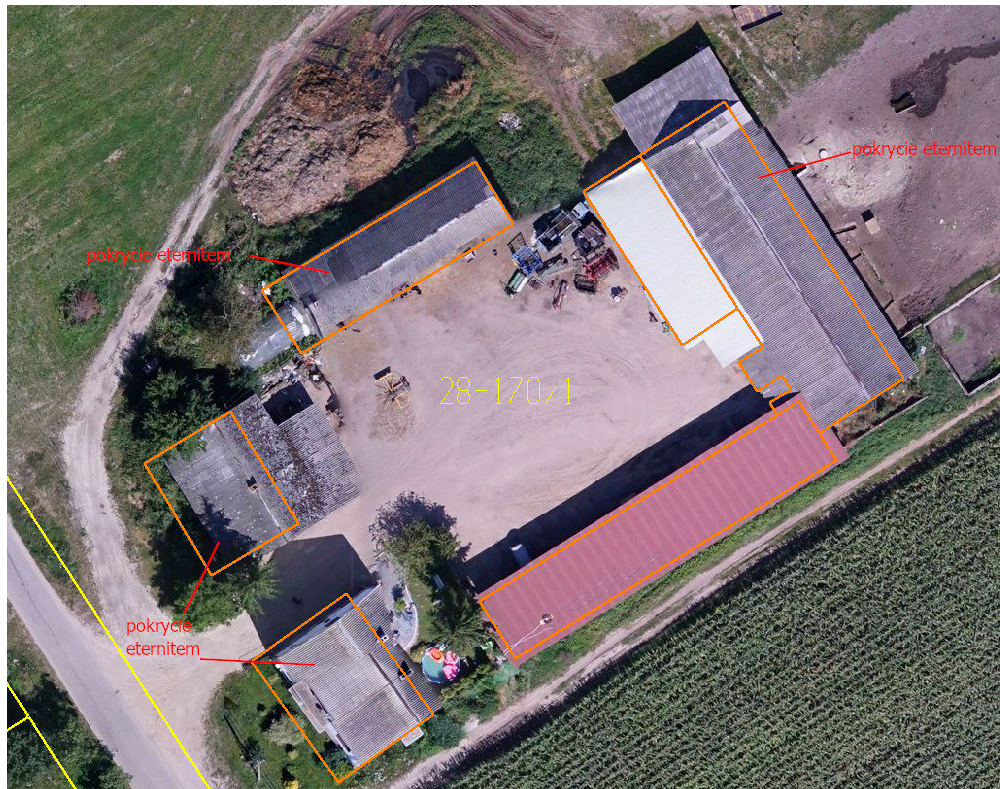
Fot. 24. Budynek pokryte eternitem - wieś Słończewo.
