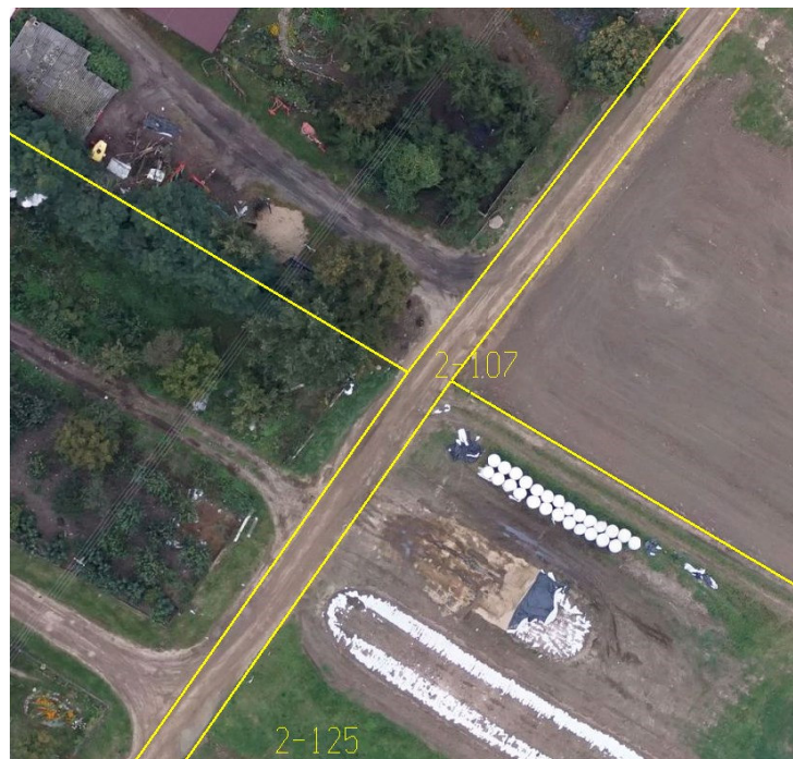
Fot. 19. Droga powiatowa w złym stanie – wieś Borza-Strumiany.
