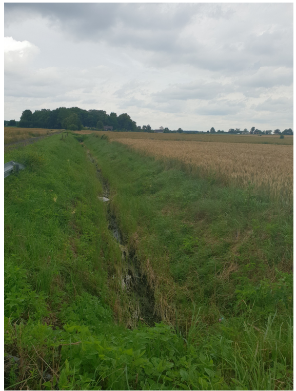
Fot. 29. Rów melioracyjny w dobrym stanie - wieś Pękowo.
