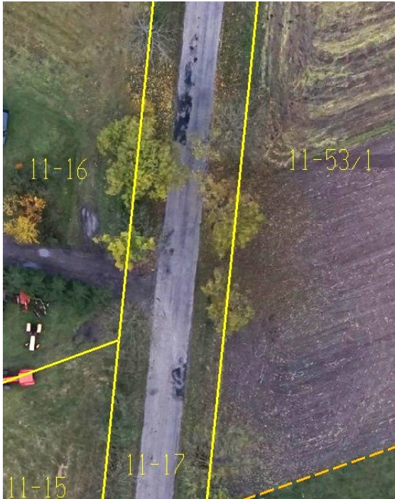
Fot. 17. Droga powiatowa w złym stanie – wieś Kozłówka.
