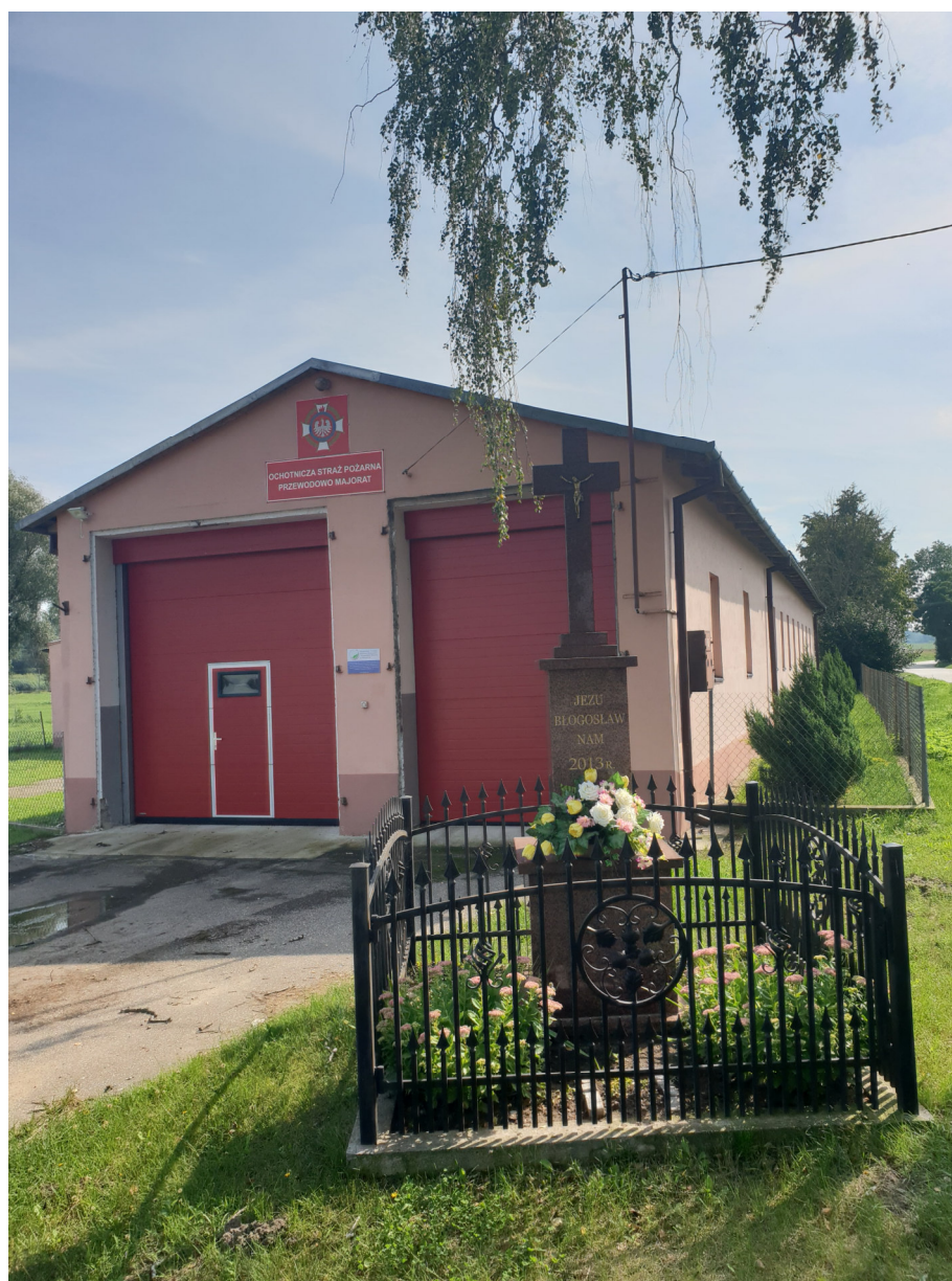
Fot. 13. Budynek Ochotniczej Straży Pożarnej w Przewodowie-Majorat.
