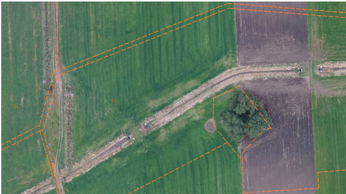
Fot. 30. Rów melioracyjny w dobrym stanie, przebieg niezgodny z ewidencją gruntów i budynków - wieś Nowe Skaszewo.
