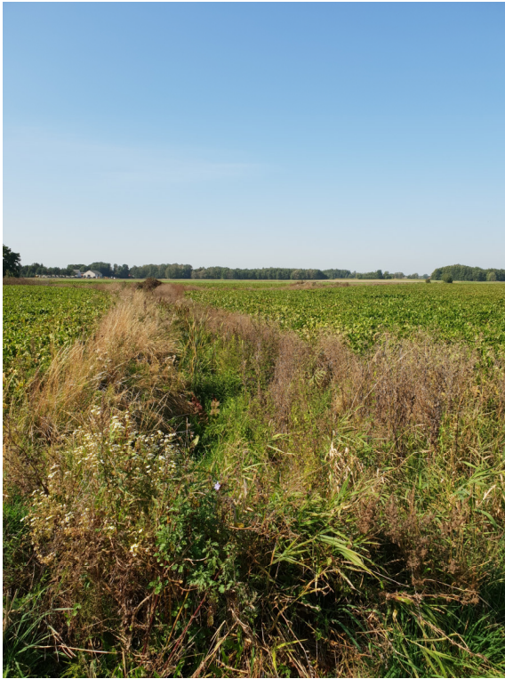
Fot. 28. Rów melioracyjny w złym stanie - wieś Mierzeniec.
