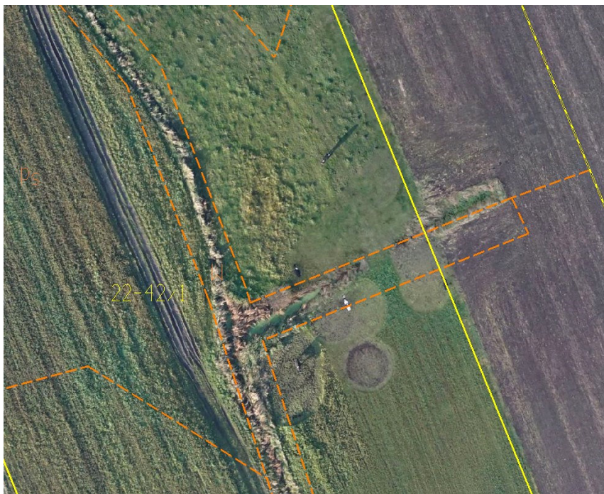
Fot. 33. Rów melioracyjny w złym stanie - wieś Porzowo.
