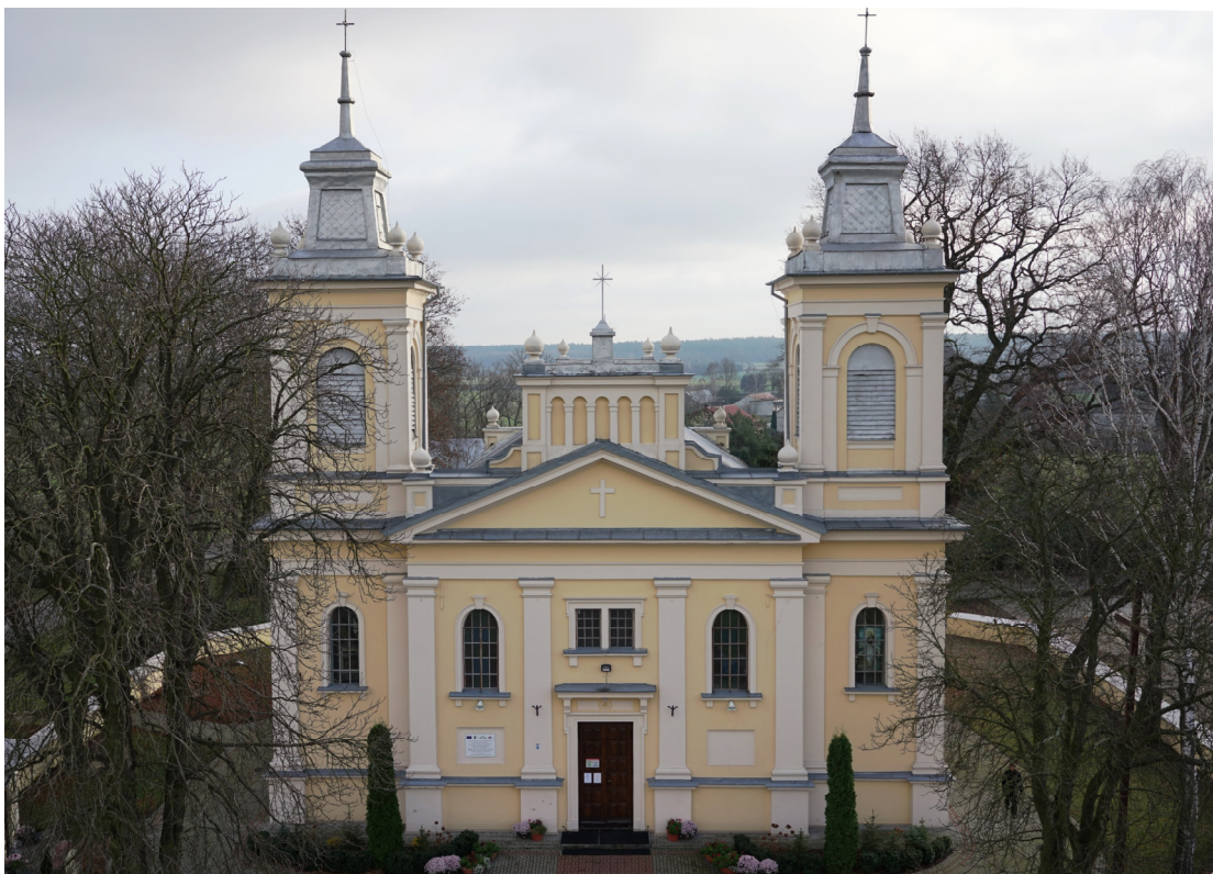
Fot. 6 Kościół p.w. Św. Anny w Przewodowie Poduchownym.
