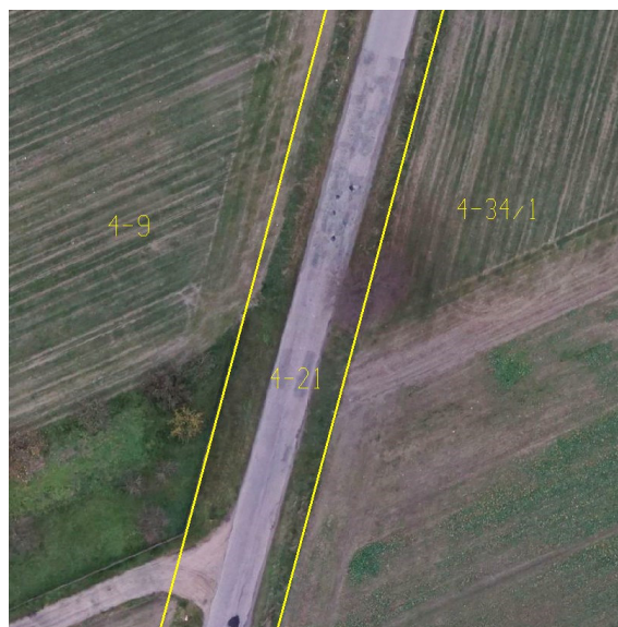
Fot. 18. Droga powiatowa w złym stanie – wieś Grochy-Imbrzyki.
