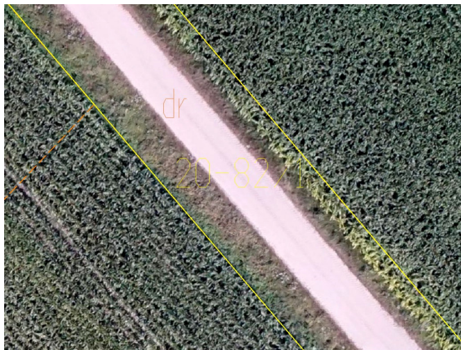
Fot. 15. Droga o nawierzchni żwirowej – wieś Ostaszewo-Włuski.
