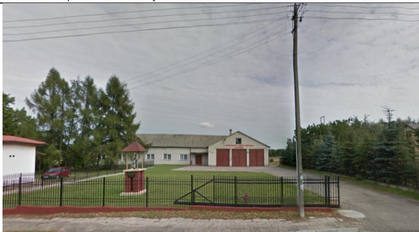
Fot. 7. Budynek Ochotniczej Straży Pożarnej w Gzach
