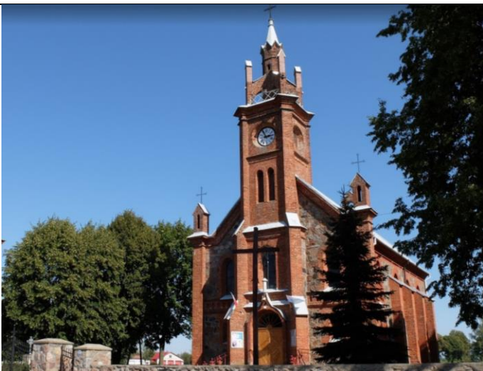
Fot. 5. Kościół pw. Wniebowzięcia NMP w Gzach
