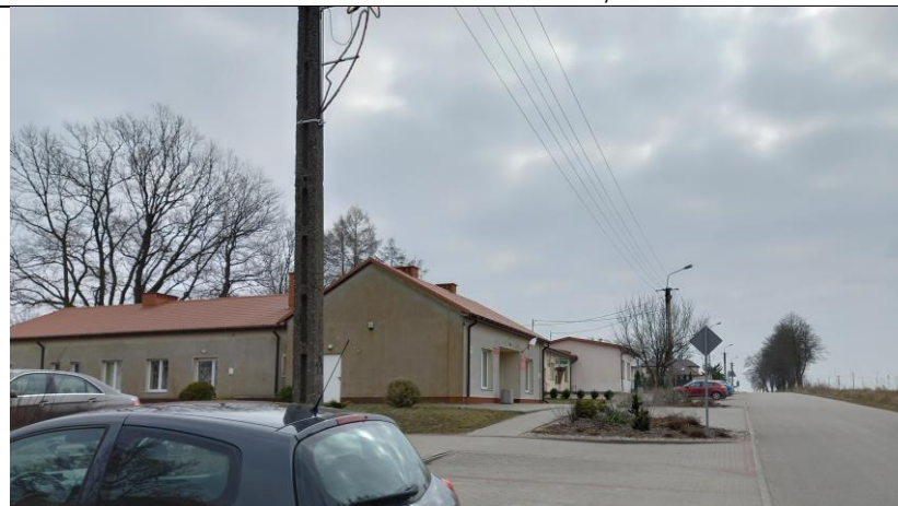
Fot. 8. Widok na budynki usługowe w Gzach
