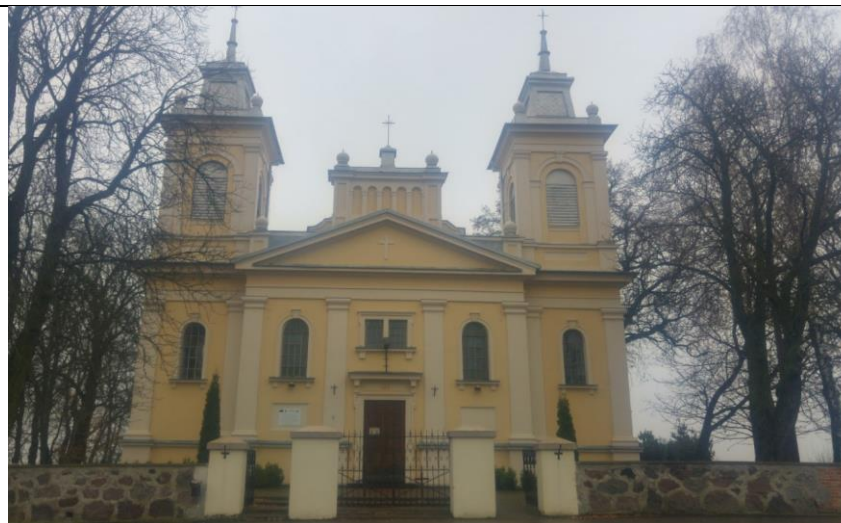
Fot. 6 Kościół św. Rocha w Przewodowie Poduchownym
