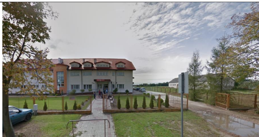
Fot. 2. Budynek Gminnej Biblioteki Publicznej w Gzach
